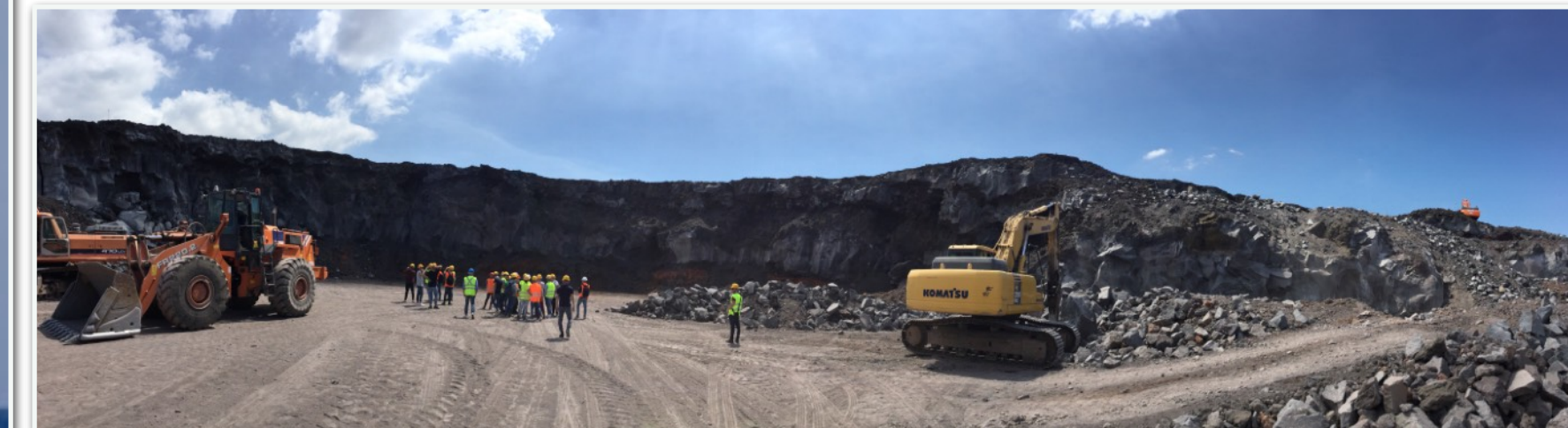
Studio dei mezzi di scavo
