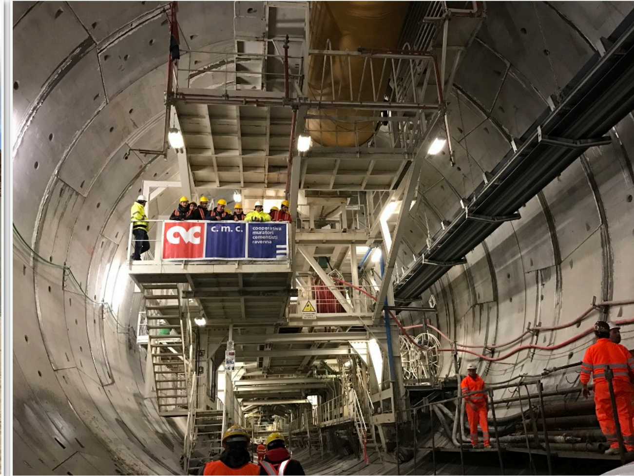
Realizzazione galleria con TBM
